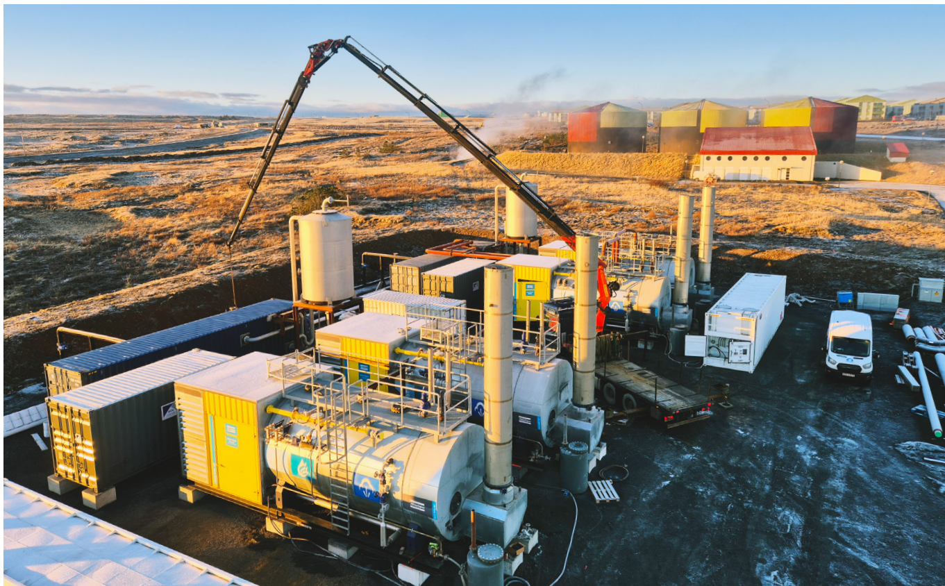
Ef afhending á heitu vatni stöðvast aftur vegna eldgoss munu neyðarstöðvarnar sjá til þess að hægt er að halda veitukerfum frostfríum og draga úr líkum á frostskekkjum fasteigna á svæðinu.
