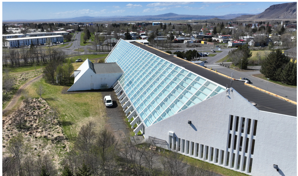
Bygging Fjölbautaskóla Suðurlands á Selfossi. Hið feikistóra hallandi glerpak er eitt helsta einkenni hússins. Mynd: Héðinn
