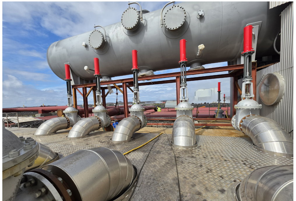
Önnur af nýju gufuskiljunum eftir að hún var hífð á tímabundinn sleða áður en hún er dregin inn í hús. Mynd: Héðinn
